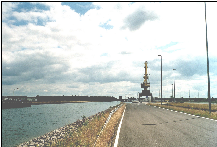
Bild 4: Hafen Eberswalde (Schwerlastkran, RoRo-Rampe)
