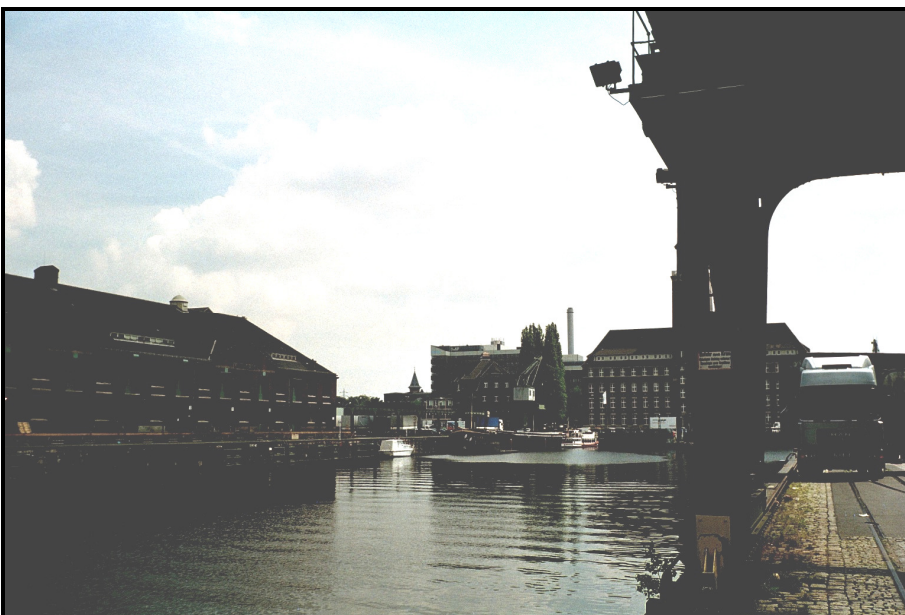
Bild 2: BEHALA Westhafen (Verwaltung Packing Storage)
